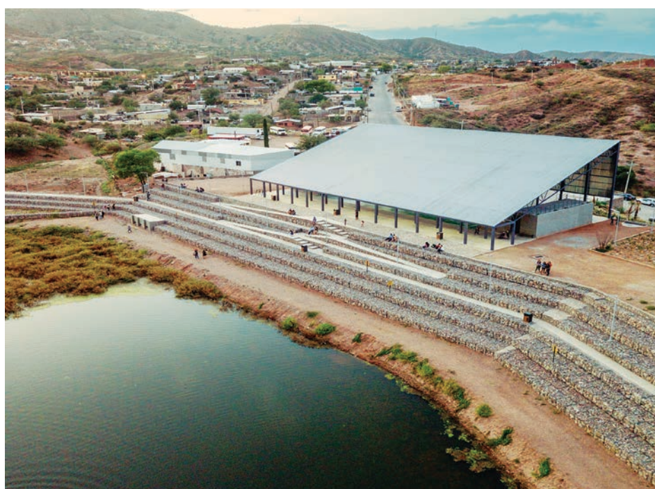
Regulación del agua mediante una válvula de escape y un sistema de muros de retención de gaviones de piedra.
